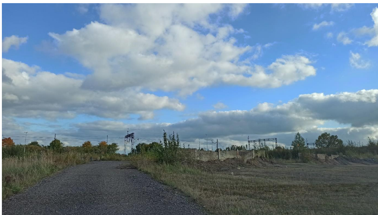
Zdjęcie 2 Widok na istniejący przejazd kolejowy
