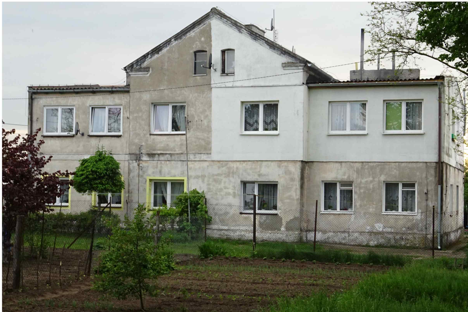
Dwór - elewacja południowo-wschodnia
