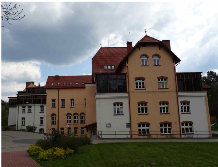
Budynek główny - elewacja zachodnia
