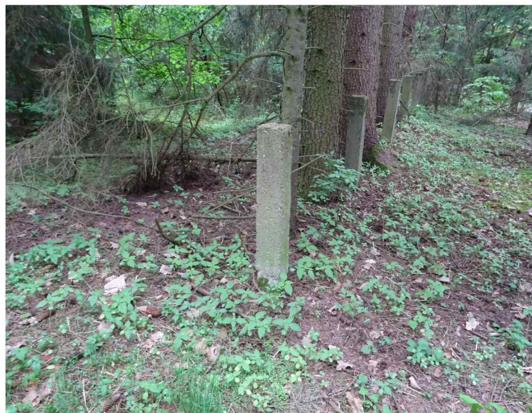
Stłupki ogrodzenia cmentarza
