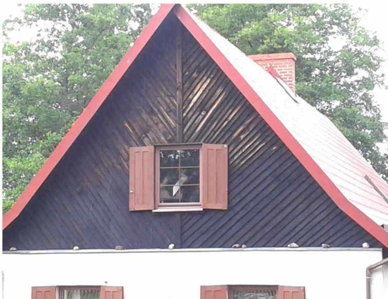
Deskowanie ściany szczytowej poddasza
