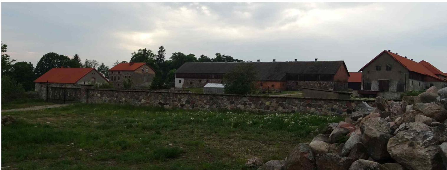
Budynki zespołu - widok od południa
