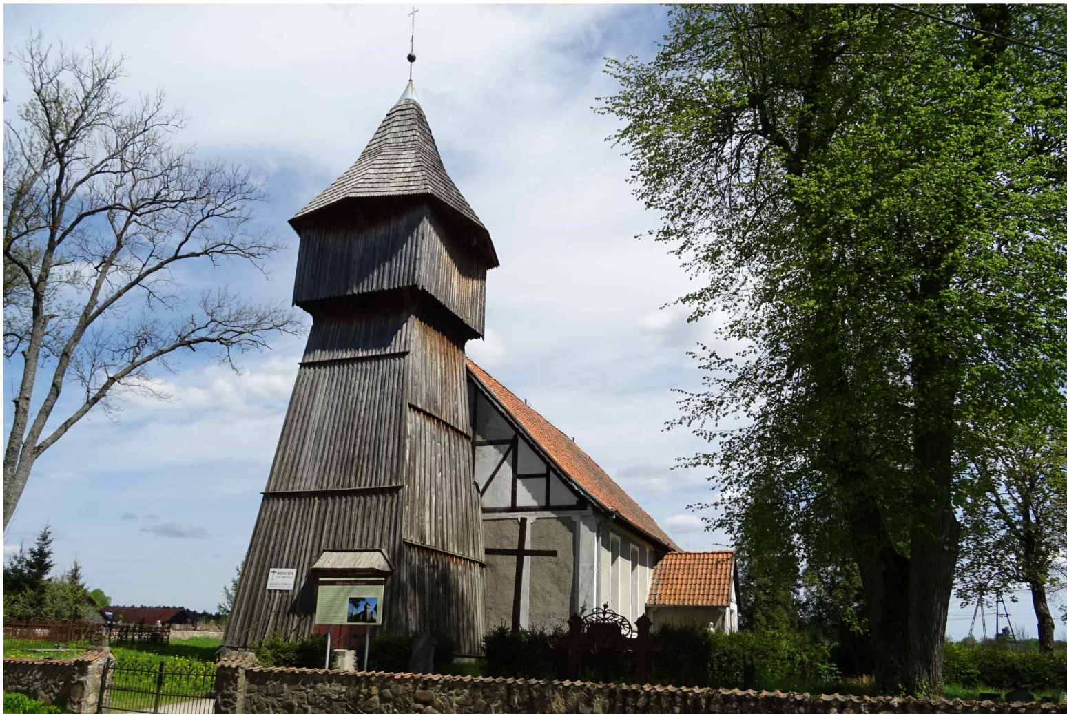
Elewacja od strony drogi dojazdowej
