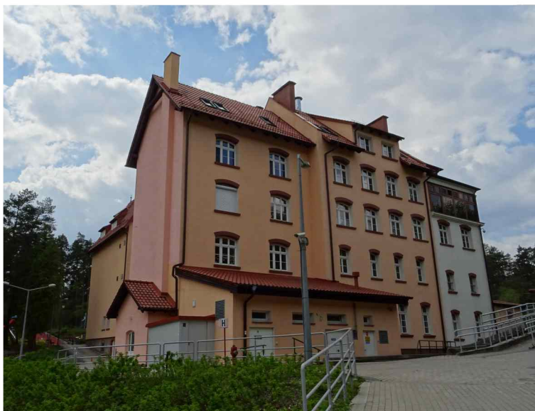
Budynek główny - elewacja północna i wschodnia
