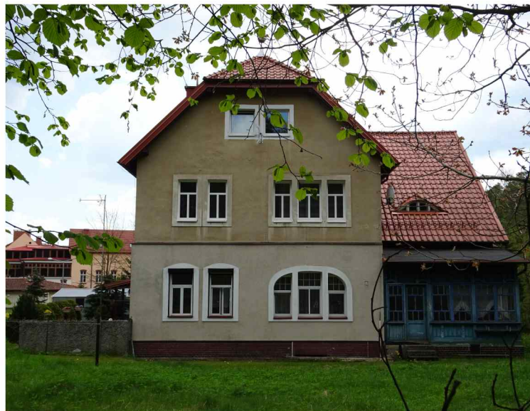
Willa - elewacja zachodnia
