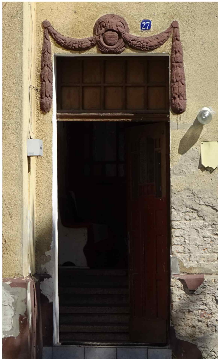
Wejście do budynku
