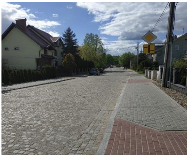
Modernizacja nawierzchni ulicy Grunwaldzkiej (zdjęcie z zasobów własnych Urzędu Miejskiego w Olsztynku)
