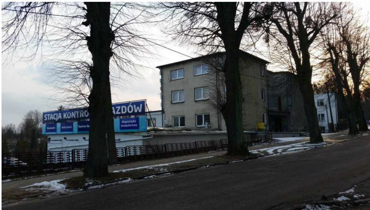
Zdjęcie 6: Zabudowa usługowa – stacja kontroli pojazdów i budynek wielorodzinny położony przy ulicy Zajęczej. Widoczny szpaler starodrzew gat. topola i klon sąsiadujący z terenem objętym projektowanym mpzp.
