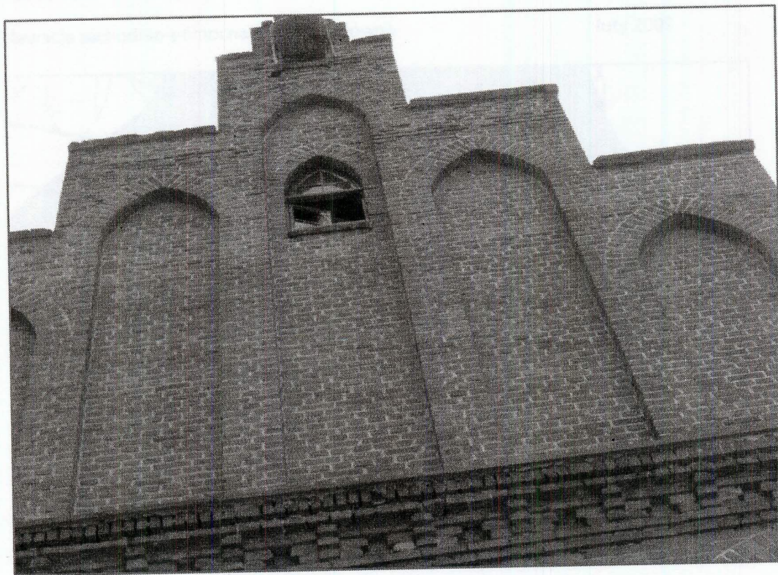
Elewacja południowa – nawa poprzeczna
