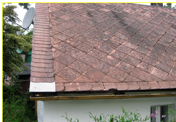
Fot. 2 Płyty azbestowo-cementowe płaskie
