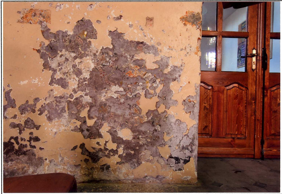
Widok narożnika po stronie północnej. Widoczne złuszczone płyty tynku cementowego.
