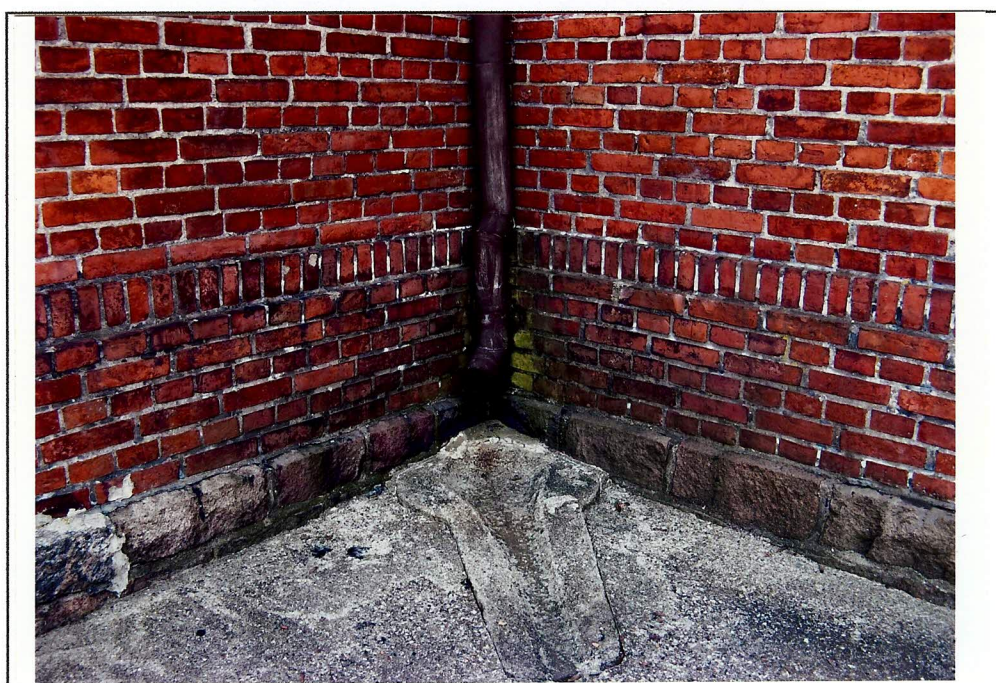
Widok narożników od południa.
