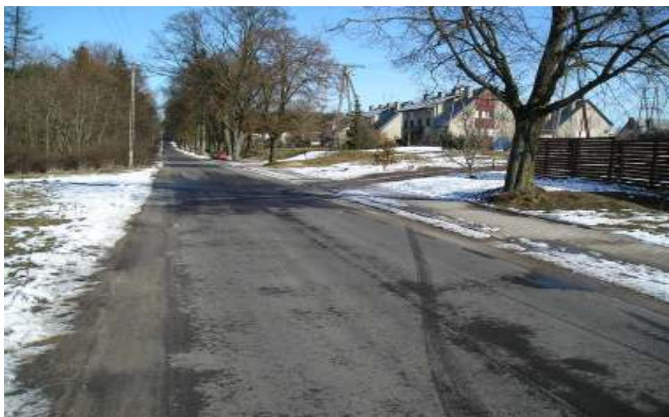
Fot. 1. Ul. Leśna - skrzyżowanie z drogą powiatową - początek opracowania.
