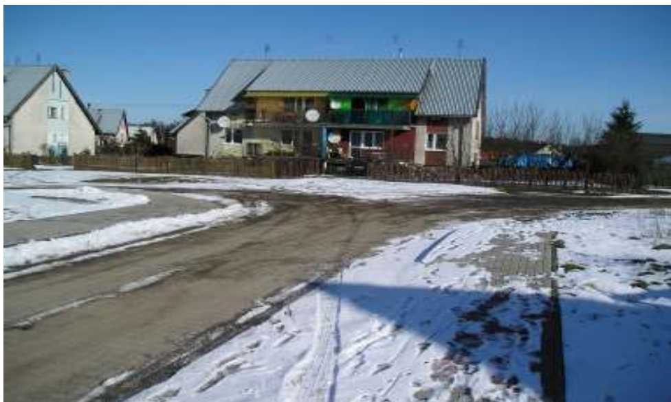
Fot. 5. Widok z łącznika w kierunku ul. Owocowej.
