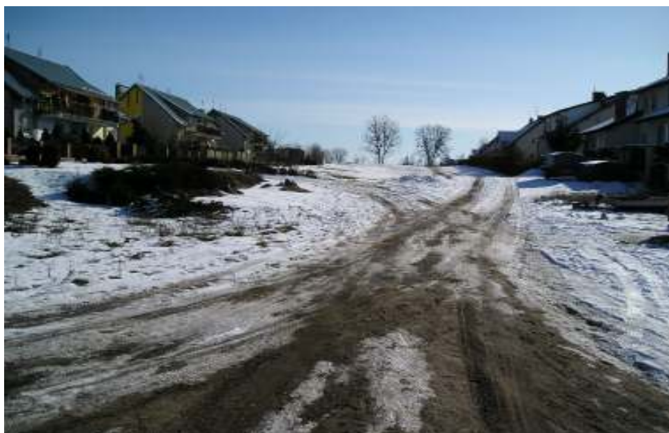
Fot. 2. Pas drogowy ul. Owocowej - widok w kierunku DK 51.
