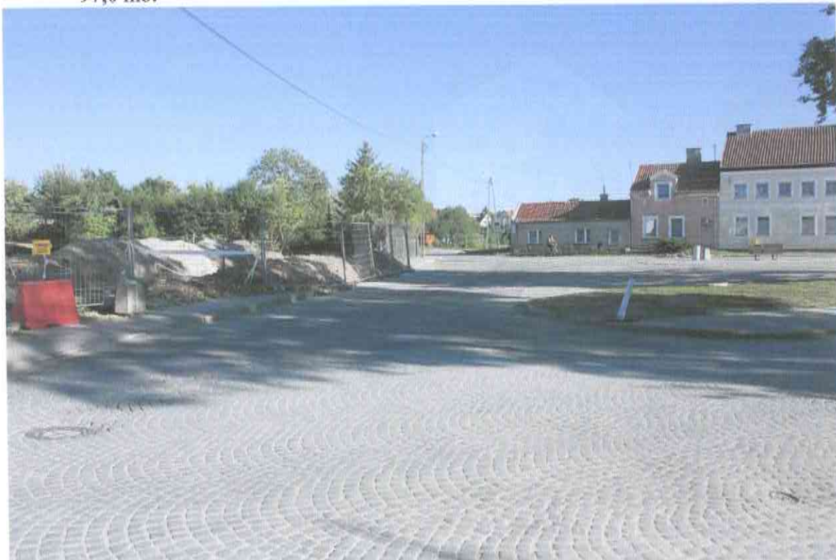
Ulica Strażacka – widok od ulicy Jagiełły (zdjęcie własne).
